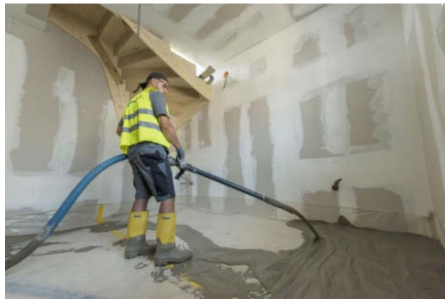
Abbildung 5: Vor-Ort-Foto der Ausgleichsschüttungs-Anwendung von Airium – Quelle: PERLMOOSER Beton GmbH
