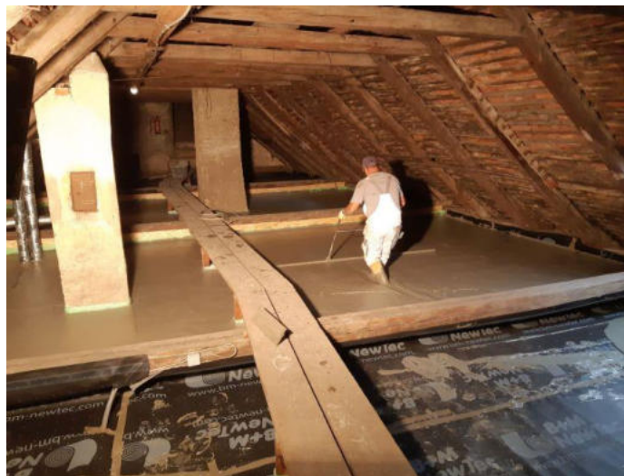
Abbildung 6: Vor-Ort-Foto der Dachbodendämmung-Anwendung von Airium – Quelle: PERLMOOSER Beton GmbH
