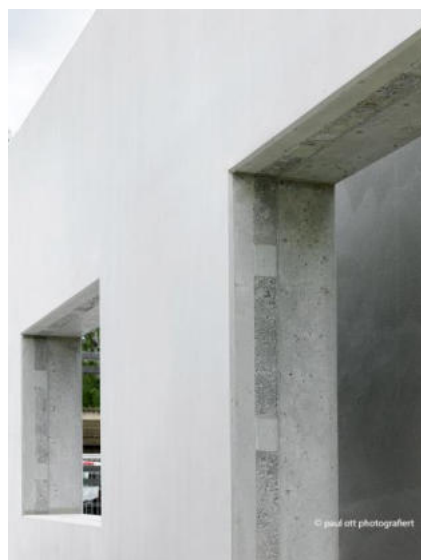
Abbildung 3: Foto eines mit Airium gefüllten Sandwichwandelements – Quelle: PERLMOOSER Beton GmbH
